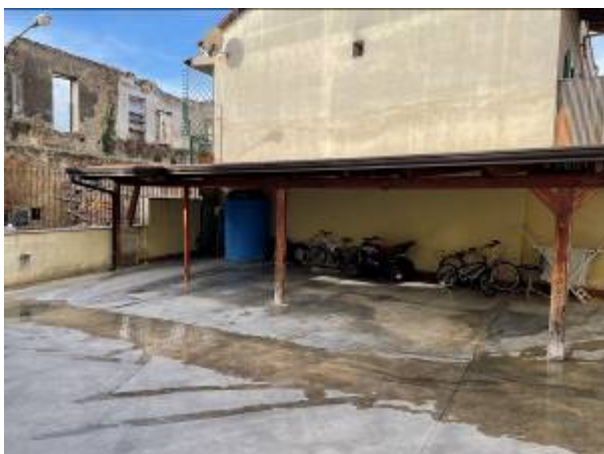
Fotografia n. 5 _ Tettoia posta a protezione dei posti auto
