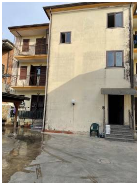
Fotografia n. 2 _ Prospetto sulla corte
