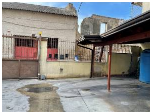
Fotografia n. 6 _ Posizionamento del posto auto sub 9 in rapporto all'ingresso carrabile
