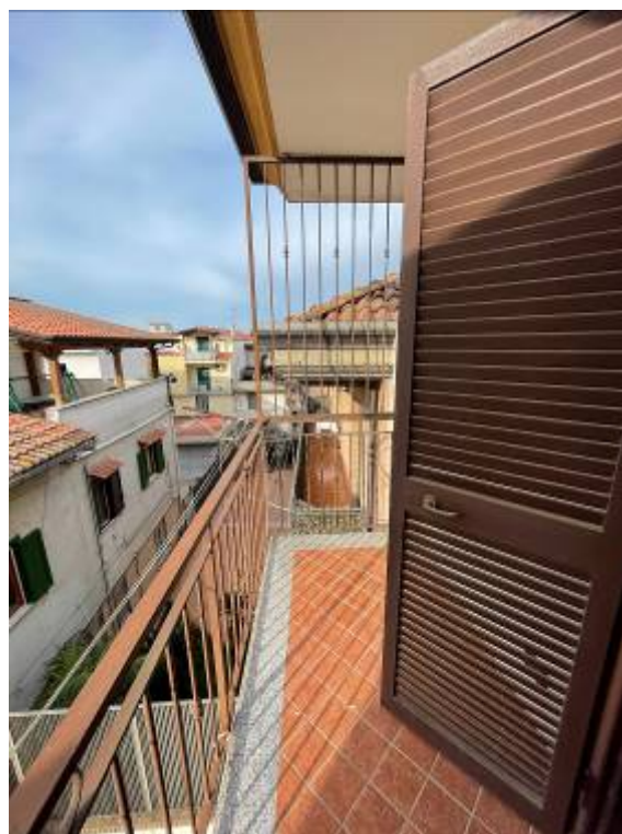
Fotografia n. 8 _ Balcone sud sub 6 vista e/o
