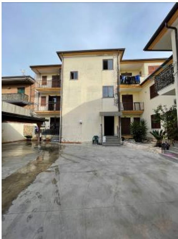
Fotografia n. 1 _ Prospetto sulla corte
